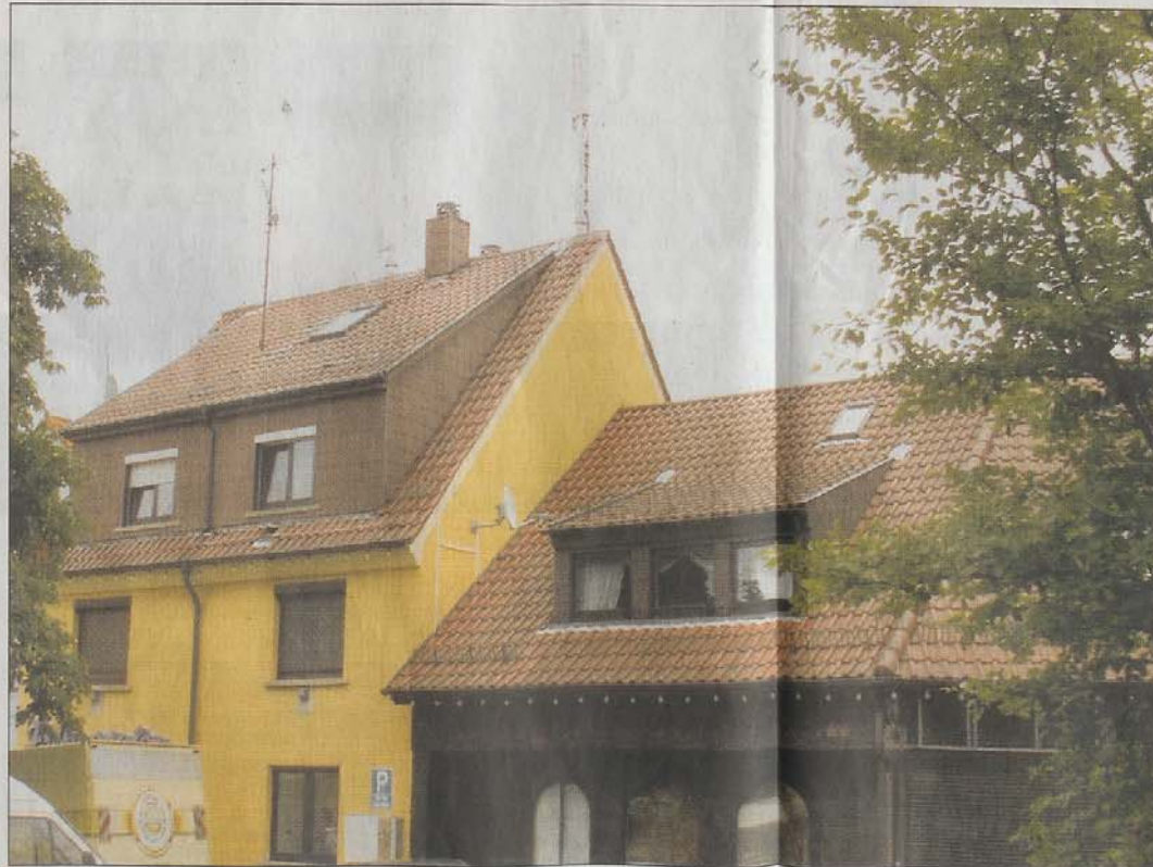
Diese Mobilfunk-Antennen am Kelterplatz stören die Anwohner, eine Anlage ist fertig installiert, von der zweiten ist nur der Antennenträger zu sehen. Nachbarn fordern den Abbau und dass sich die Stadt mehr einsetzt. Foto: Frey
